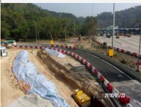
將軍澳道支路鋪設雨水渠
